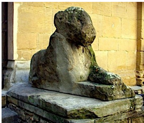
4.11. kép. Savas csapadék hatása épület kőfaragványán (forrás:
